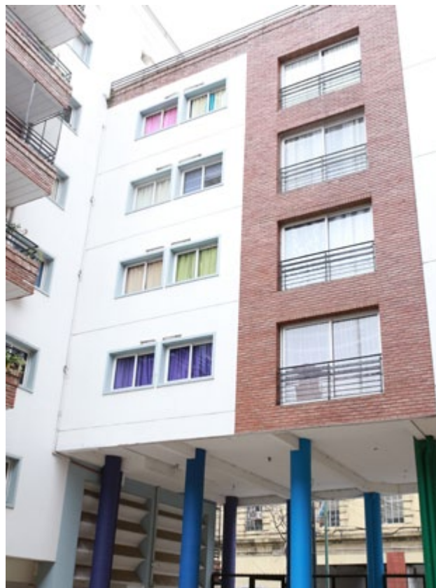
Contrafrente del complejo habitacional
