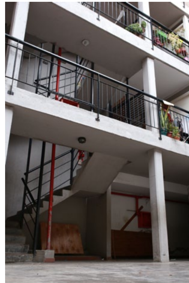
Escaleras de circulación interna
