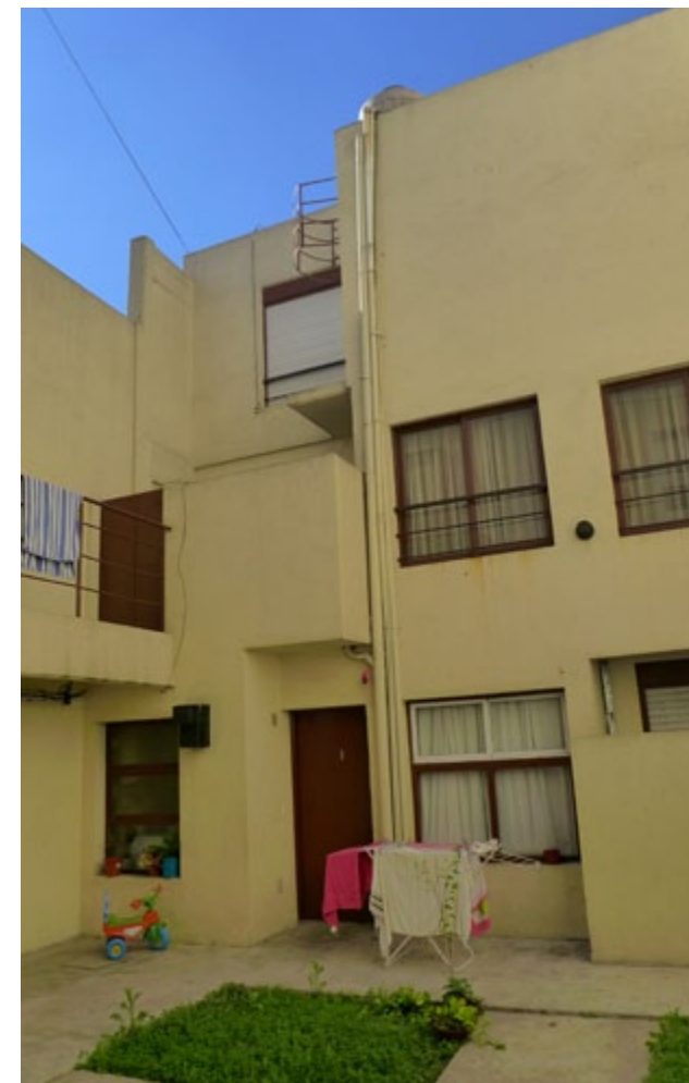
Contrafrente del complejo habitacional
