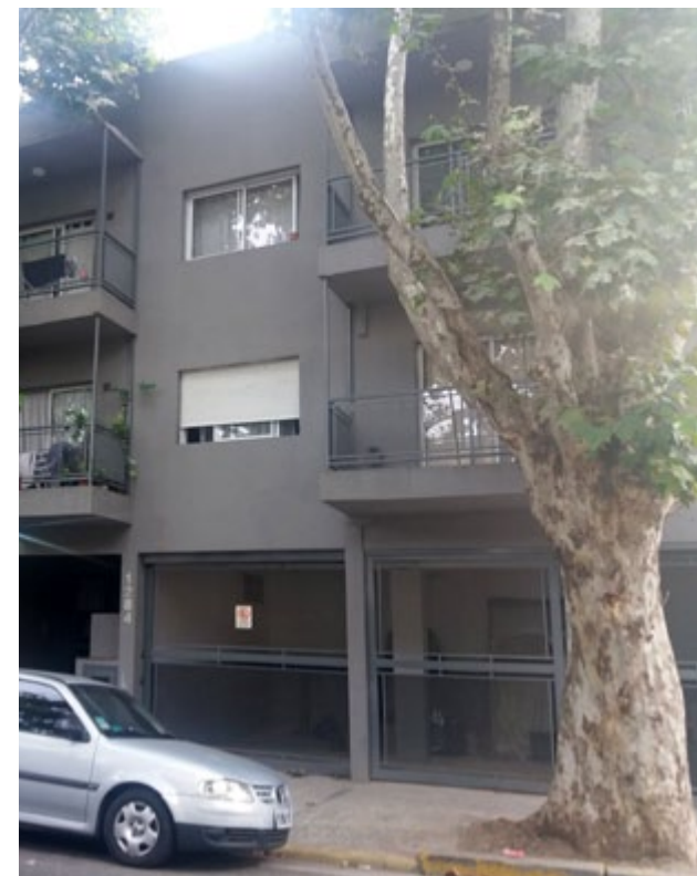
Vista lateral del edificio
