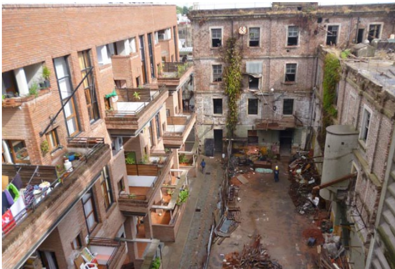
Foto panorámica de los tres módulos del complejo habitacional en obra
