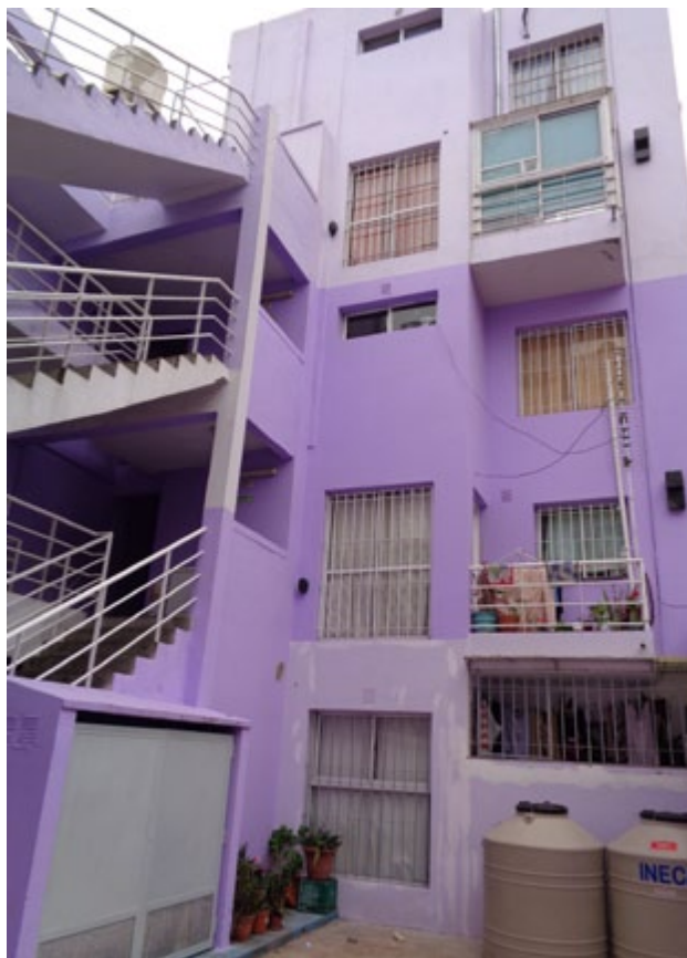
Contrafrente del complejo habitacional
