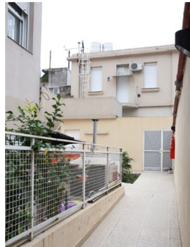
Pasillo interno de circulación
