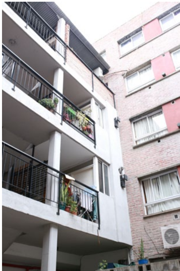
Contrafrente del complejo habitacional
