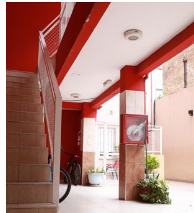
Patio y escalera de circulación interna
