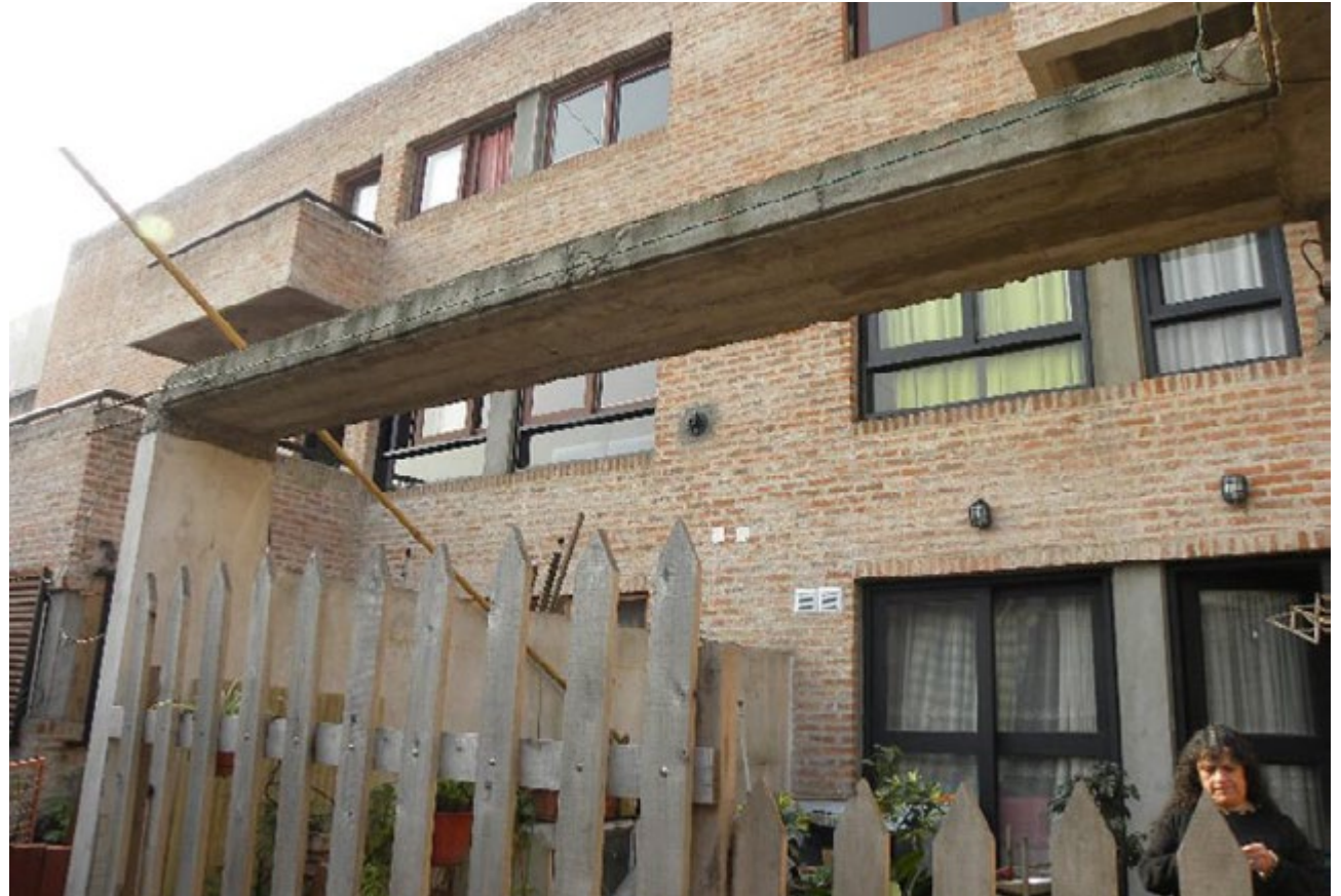
Frente lateral interno del inmueble en obra
