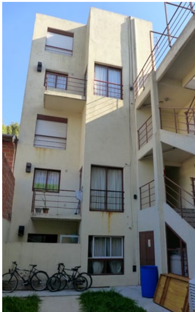
Contrafrente del complejo habitacional
