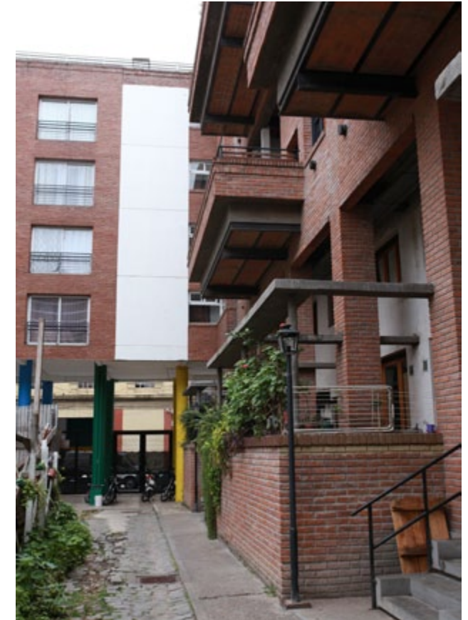
Pasillo interno de circulación
