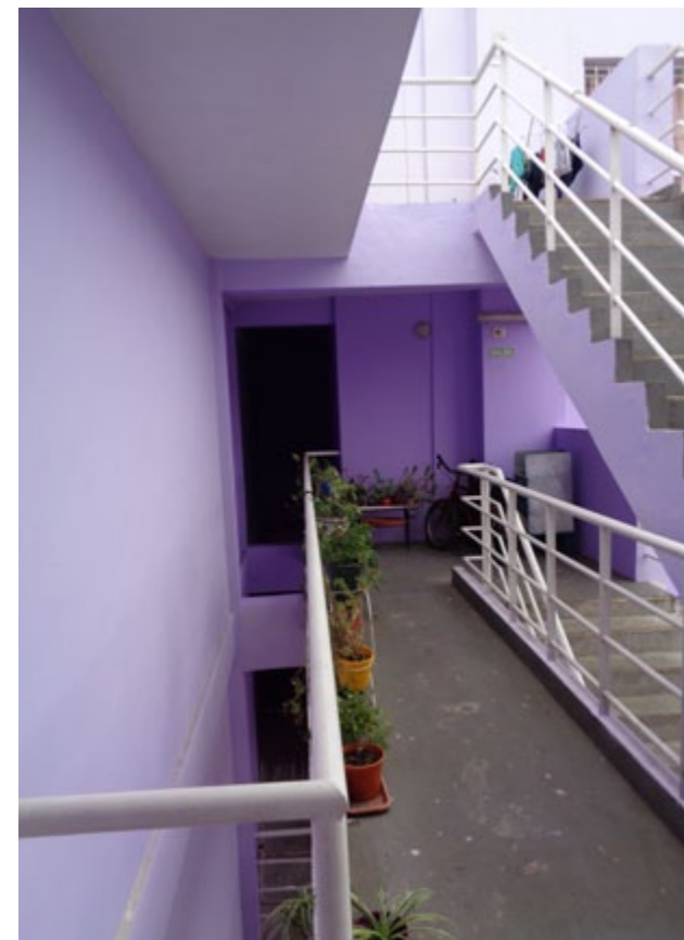
Pasillo interno de circulación
