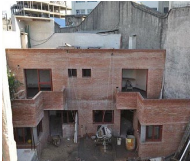
Modulo del fondo en obra
