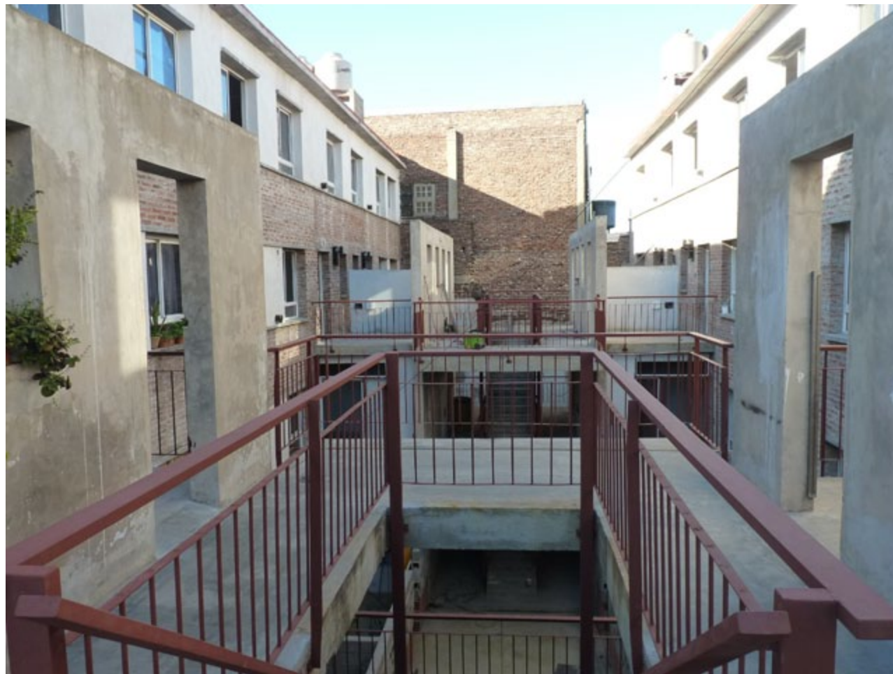
Escaleras de circulación interna
