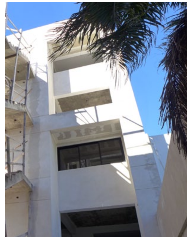
Contrafrente del complejo habitacional
