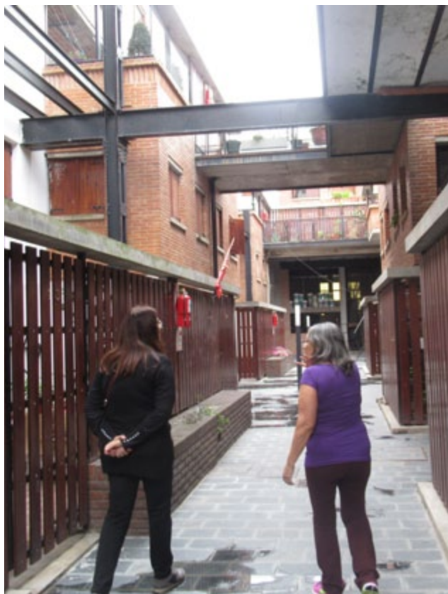
Pasillo interno de circulación
