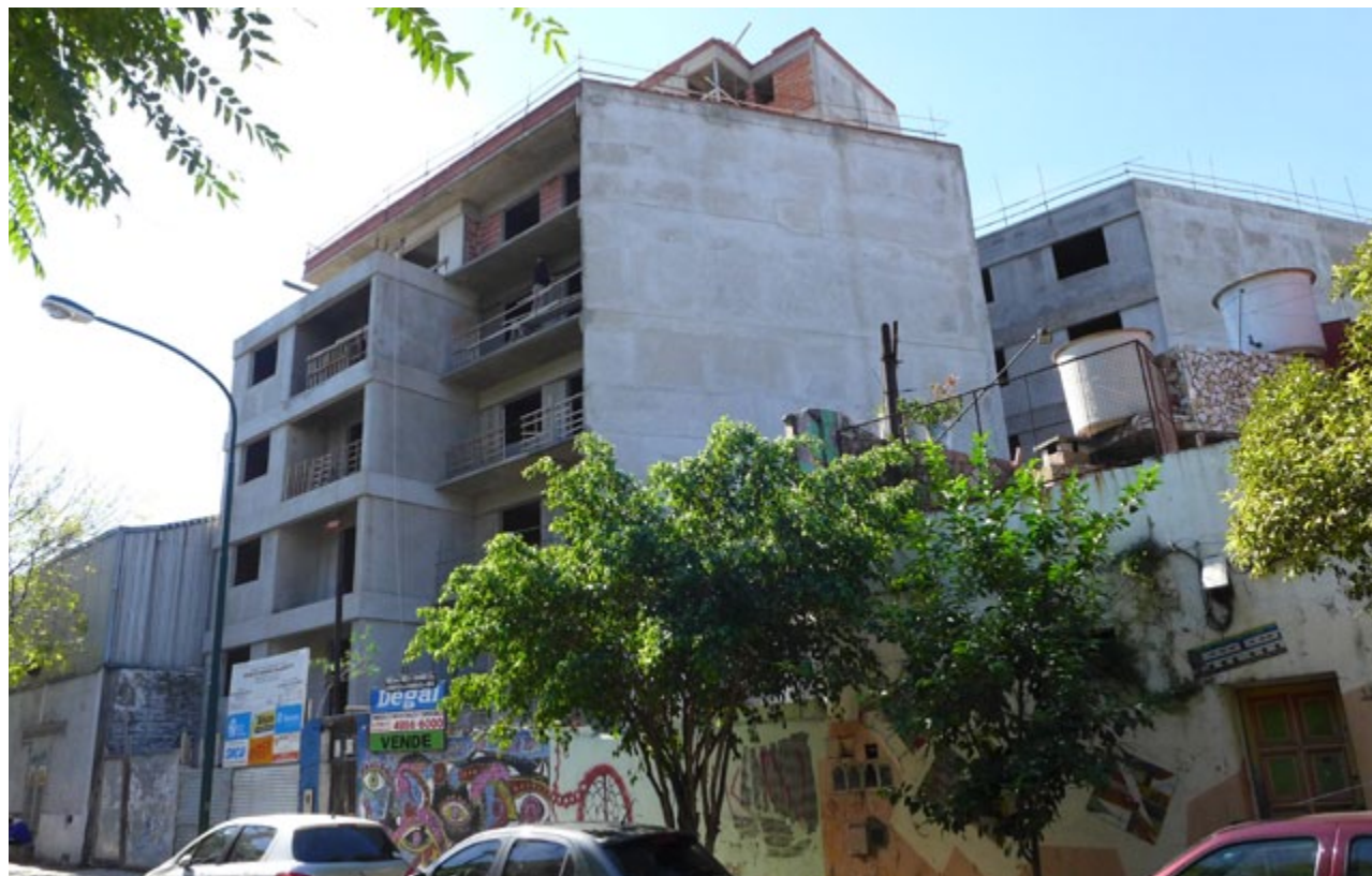
Frente lateral del inmueble en obra
