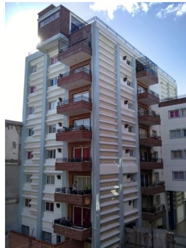
Contrafrente del complejo habitacional
