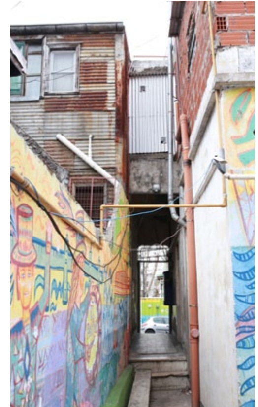
Pasillo de circulación
